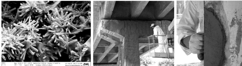
| 그림 26. BASF사 Emaco® Nanocrete repair mortar 적용 사례 |
